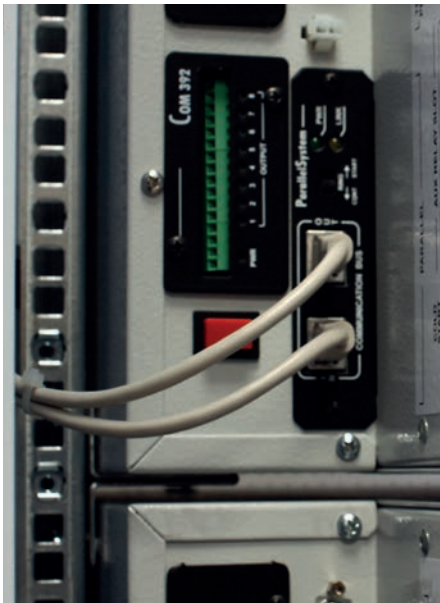
Configuración en paralelo y tarjeta de contactos de relé programables.
